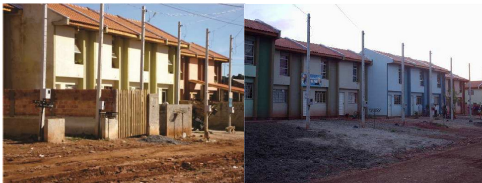
Figura 2: Habitações construídas na Vila Zumbi dos Palmares - 2007.
