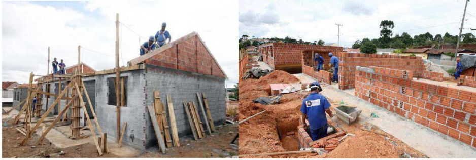
Figura 9 – Unidade em fase de construção - 2012.
