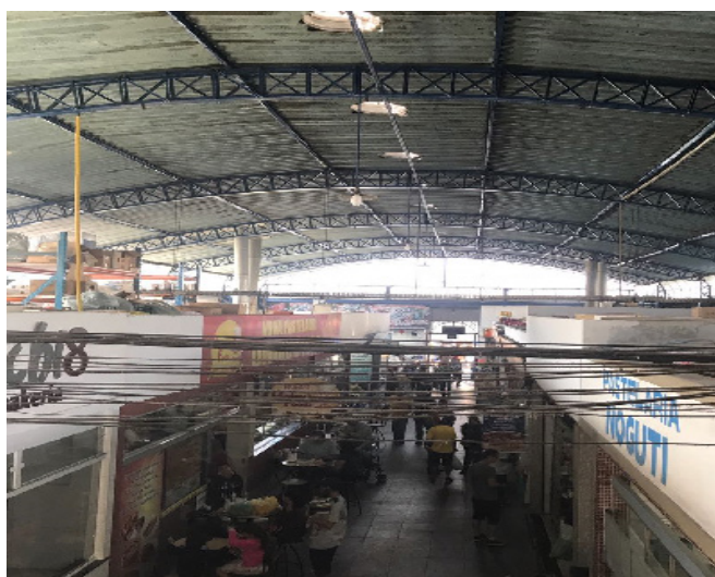
Figura 4 - Vista Interna: Cobertura Mercado Municipal 2017.
