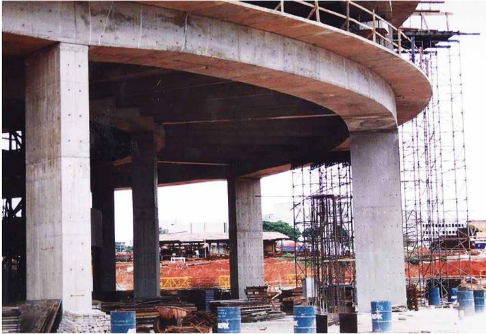
Figura 6. Pilares principais externos e internos, bloco B.
