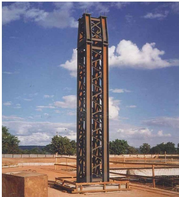
Figura 6. Pilar metálico de escoramento provisório, bloco A.
