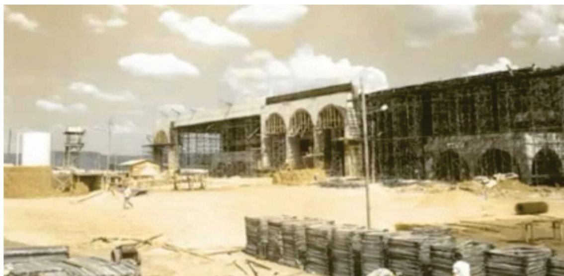
Figura 1- Construção do Palácio do Araguaia.
