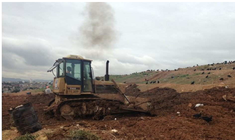
Figura 6. Fonte: Arquivo aterro sanitário 2017.
