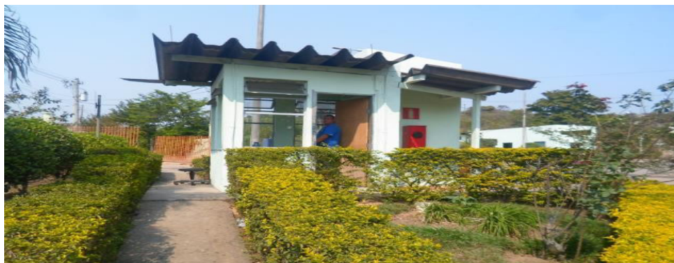
Figura 4. Fonte: Arquivo aterro sanitário 2017.
