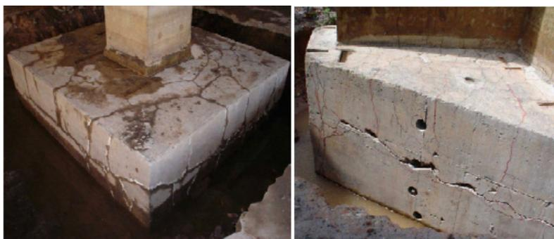
Figura 1: Fissuração de bloco de fundação afetado pelo RAA.
