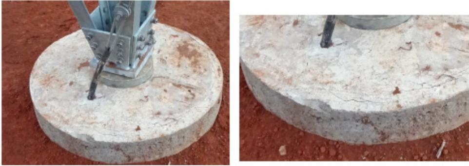
Figura 1 - Base de concreto onde fica nítida a fissuração superficial, provavelmente devida à retração por secagem do graute colocado na parte superior.
