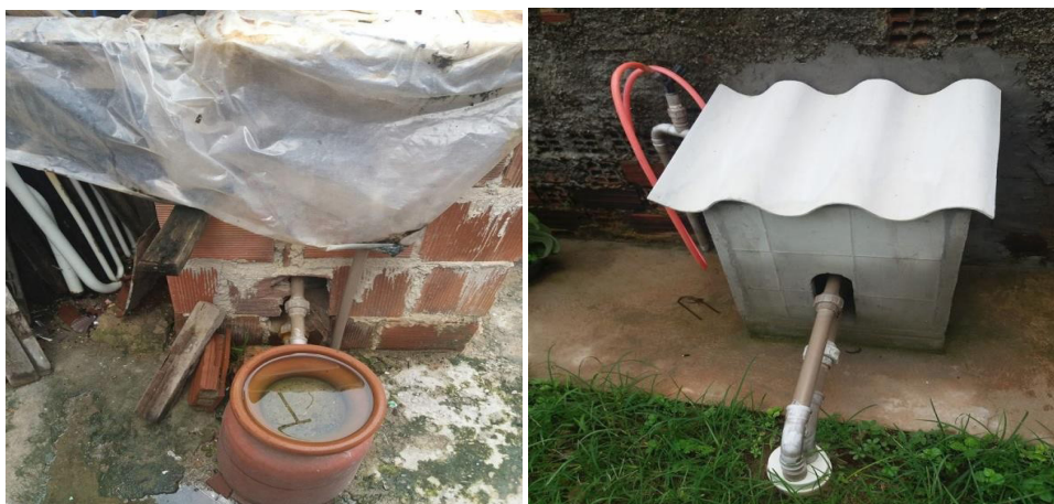
Figuras 3 e 4. Estruturas das Caixas de Bomba para os poços. Fonte: Os Autores (2020).
