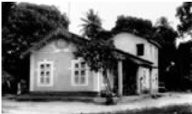
Figura 3 – Foto da Casa de Paulo Freire- Estrada do Encanamento 457, Casa Amarela. Recife.
