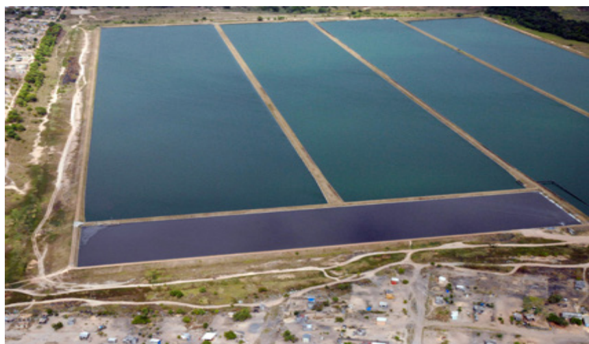
Figura 01: Lagoa de Estabilização de Boa Vista/RR.
