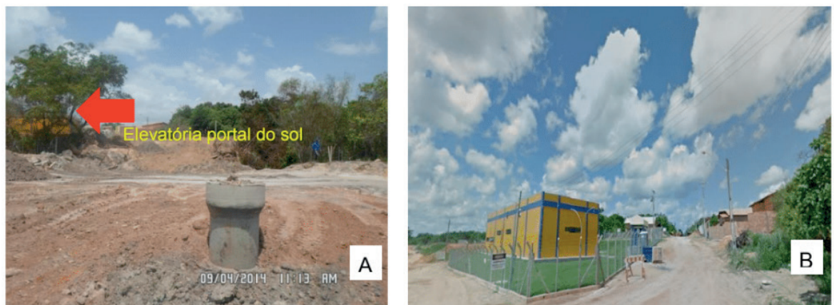
Figura 08: A - Pv (Poço de Visita) do Interceptor.
