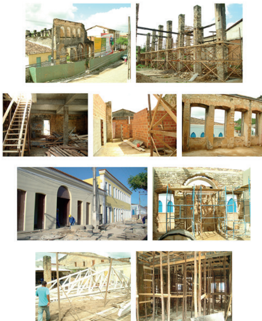
Figura 2- (acima): esquerda – Visão geral do “Trapiche Santo Antônio” no início das obras em 2008 – orçadas em R$ 2.770.530,84 (Valor descrito na Placa da Obra), execução - duração 1 ano; direita – Consolidação das colunas de pedra remanescentes (aspecto mais expressivo do conjunto); (centro acima): esquerda – Intervenção no “Casarão 159”, centro – Intervenção no pavimento superior do “Casarão 159”, direita – Intervenção nas janelas (casco remanescente) do “Casarão 159”; (centro abaixo): esquerda – Intervenção na “Extoria”, direita – Intervenção nas “Ruínas ao lado do Casarão 159”; (abaixo): esquerda – Visão geral das tesouras metálicas utilizadas no telhado de todas as edificações, direita – Escoras de sustentação para aplicação de laje de concreto na maioria das edificações pretensamente “restauradas”.
