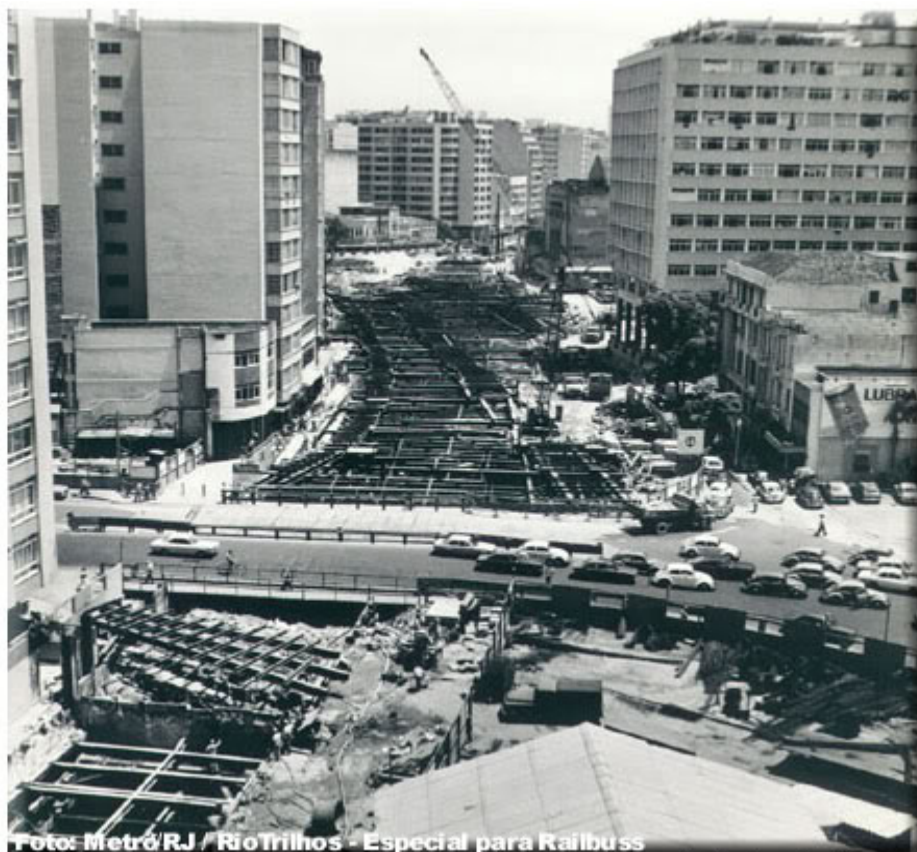
Figura 1: Obras da Estação do Largo do Machado / bairro do Flamengo.
