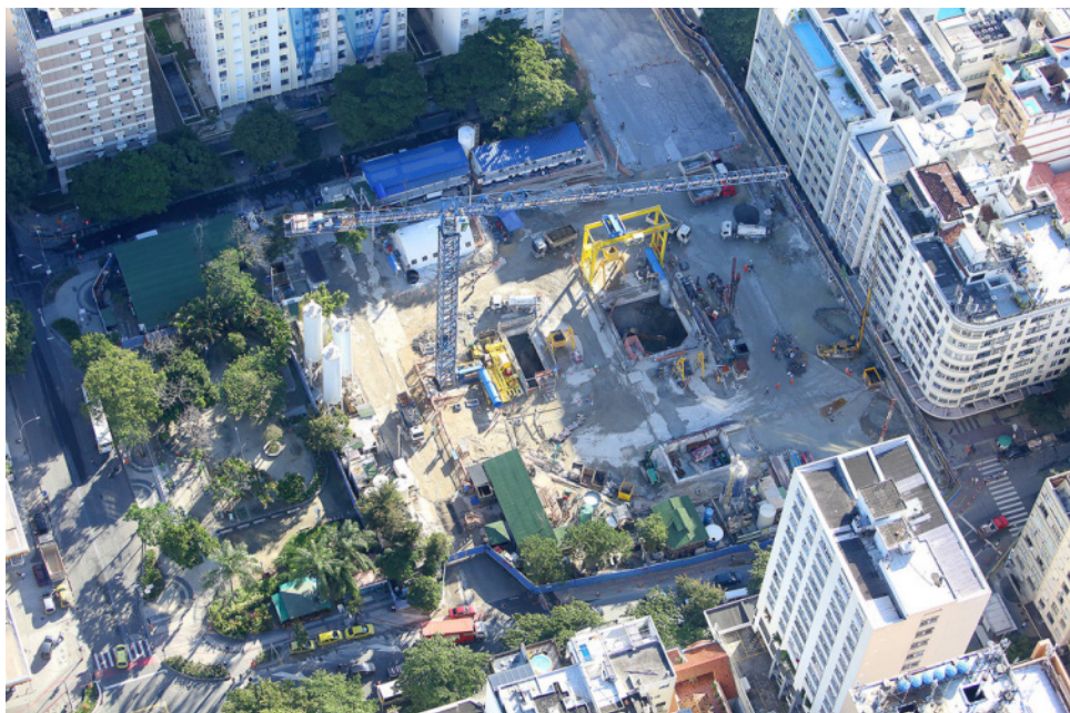
Figura 2: Canteiro de obras na Praça Antero de Quental (Leblon) em 30/05/2014.
