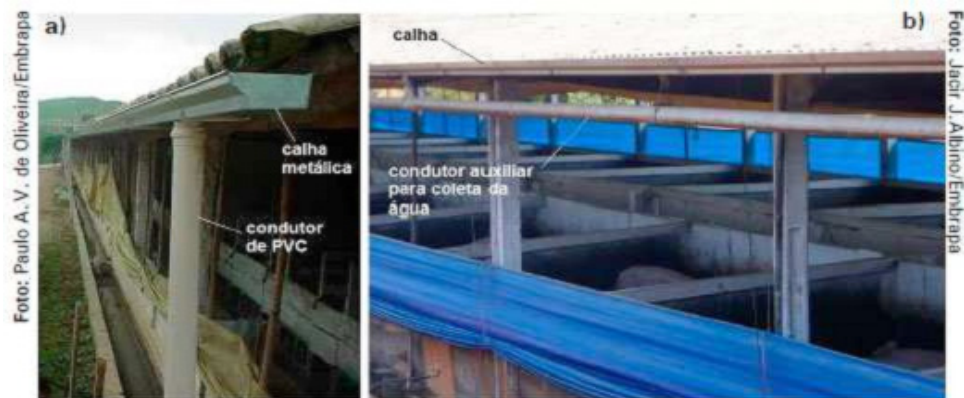
Figura 3 - Calhas e Tubos PVC instalação do sistema de calha e cano condutor
