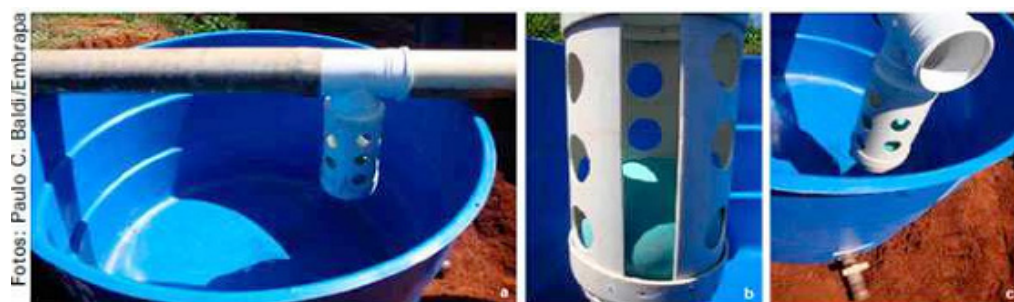
Figura 4 - Dispositivo boia para retenção da primeira água da chuva
