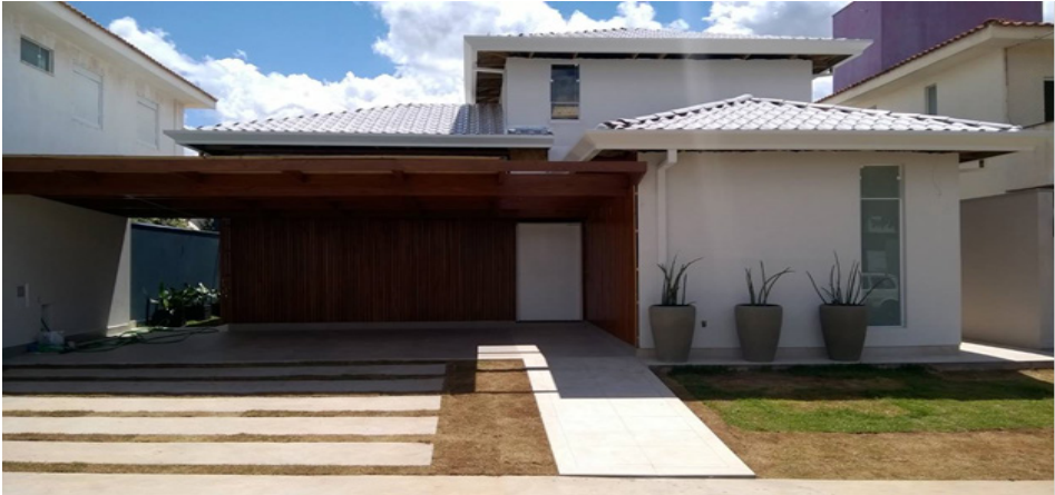
Figura 1 - Habitação em wood frame avaliada, localizada na cidade São Carlos - SP
