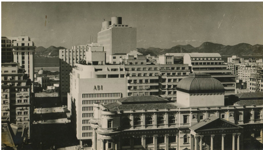
Figura 10: Região do Castelo, 1944. Foto de Epaminondas, IPHAN-RJ. Em primeiro plano, a Biblioteca Nacional, e à esquerda a rua Araújo Porto Alegre. Em segundo plano, a massa edificada do Plano Agache. Percebe-se a relação entre a sede da A.B.I. e o Palácio Gustavo Capanema e o Plano.
