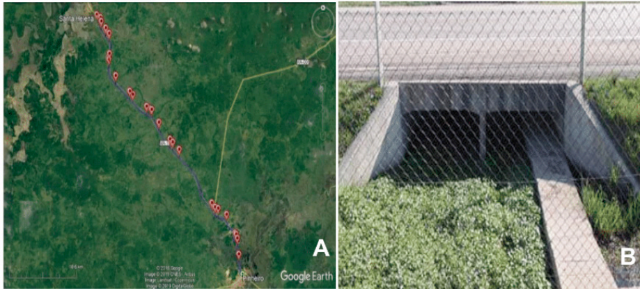
Figura 3– A) Georreferenciamento dos animais silvestres encontrados atropelados na Rodovia Estadual MA-106 (Fonte: Google Earth Pro 2019); B) Passagem de fauna subterrânea mista na rodovia BR-392/RS (Fonte: Abra (2012))
