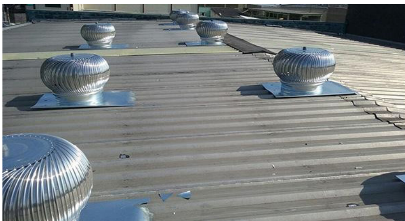
Figura 2: Modelo de exaustores eólicos indicados para serem instalados, e corrigir o problema de falta de ventilação.
