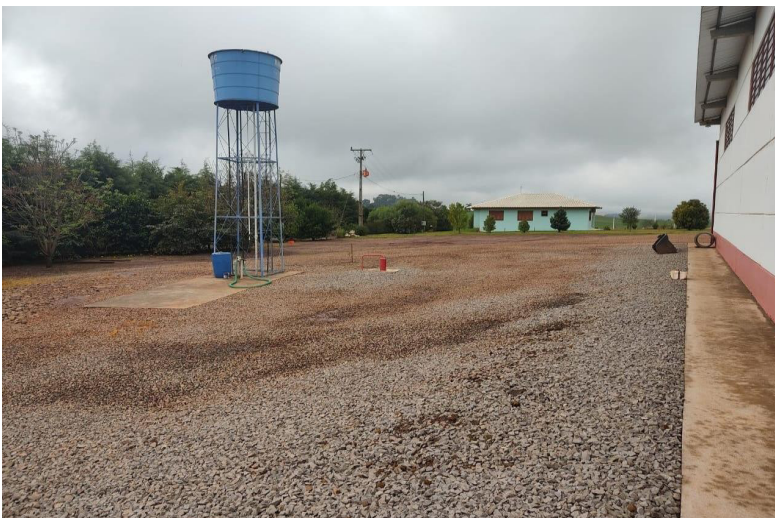
Figura 6: Local de construção do armazenamento de combustível.
