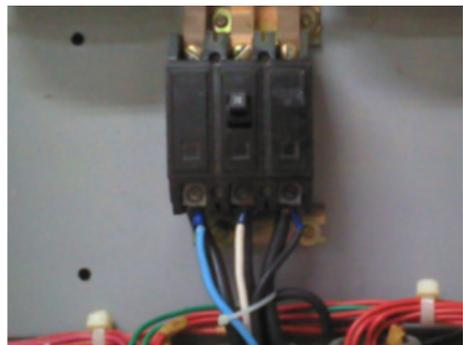
Figura 2 - Foto disjuntor tripolar
