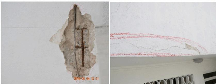
Figura 11 e 12 – Deslocamento, corrosão da armadura e fissuras causadas pela expansão do aço.
