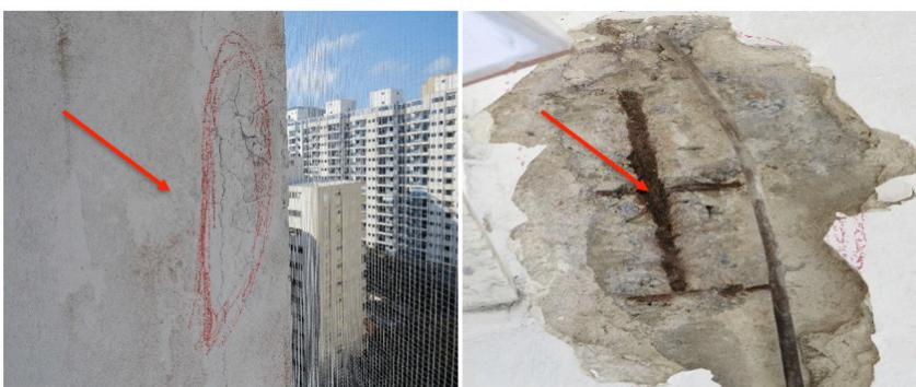
Figura 13 e 14 – Fissuras de expansão do aço, deslocamento e corrosão do aço.
