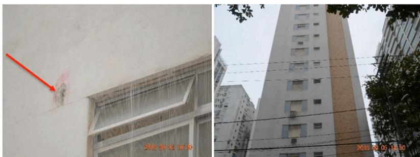
Figura 7 e 8 – Deslocamento do sistema argamassado, ausência de junta de movimentação.
