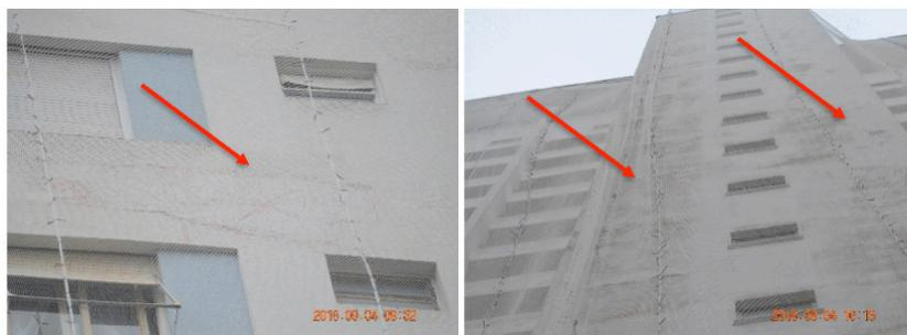
Figura 9 e 10 – Ausência de juntas de movimentação e deslocamento do revestimento.
