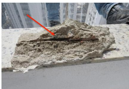
Figura 15 – Deslocamento e perda da seção do aço.
