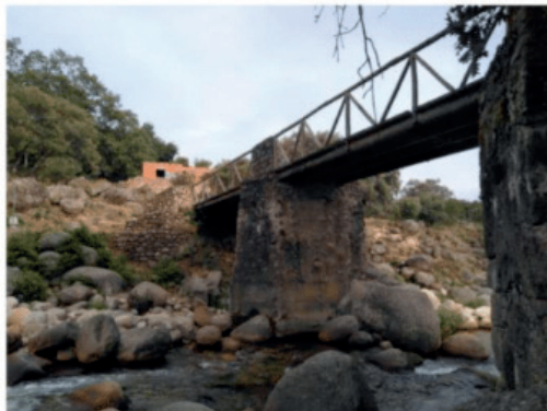
Figura 1. Puente y edificio. (Fotografía O.T)
