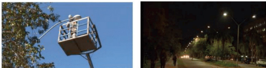
Figura 2 - Substituição das Luminárias de iluminação pública
