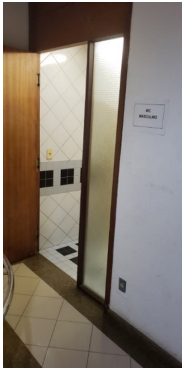
Figura 2 – Corredor de acesso ao Banheiro do piso térreo do prédio I da Reitoria UFSC
