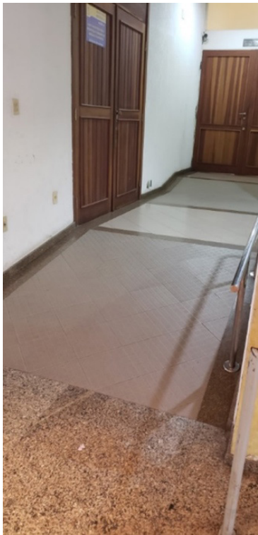
Figura 1 – Rampa de acesso ao Banheiro do piso térreo do prédio I da Reitoria UFSC
