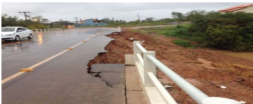
Figura 7. Pavimentação sobre o lago Bom Jardim Fonte: Dados da pesquisa, 2016.
