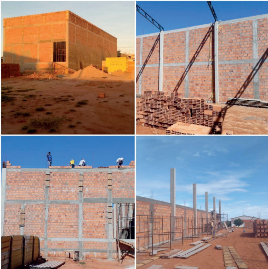
Figura 2. Implantação de todo processo de alvenaria na construção de um barracão agrícola, município de Mineiros, Estado de Goiás, 2020.
