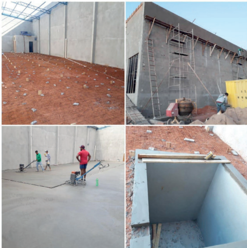
Figura 4. Implantação do reboco e concretagem, na construção de um barracão agrícola, município de Mineiros, Estado de Goiás, 2020.
