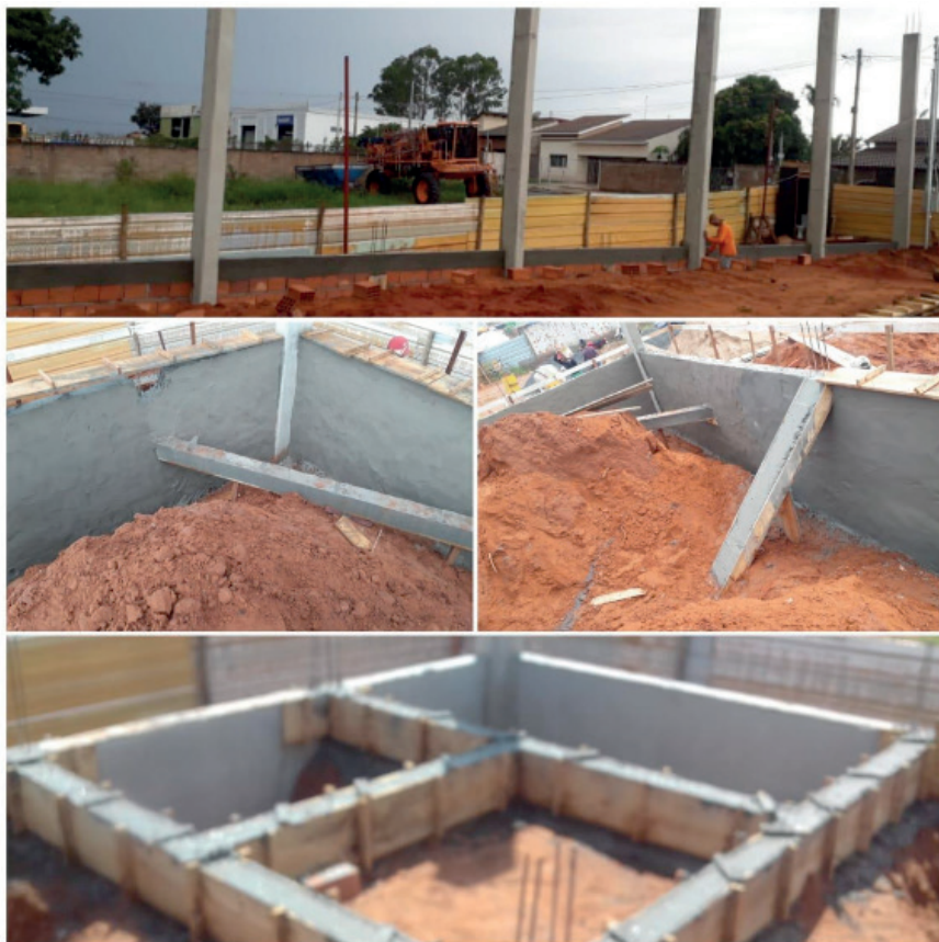
FIGURA 1. Implantação do alicerce na construção de um barracão agrícola, município de Mineiros, Estado de Goiás, 2020.
