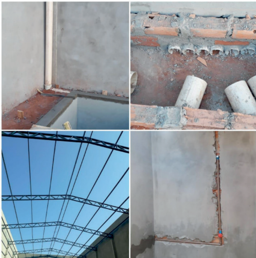
FIGURA 3. Implantação do encanamento e estruturas metálicas, na construção de um barracão agrícola, município de Mineiros, Estado de Goiás, 2020.
