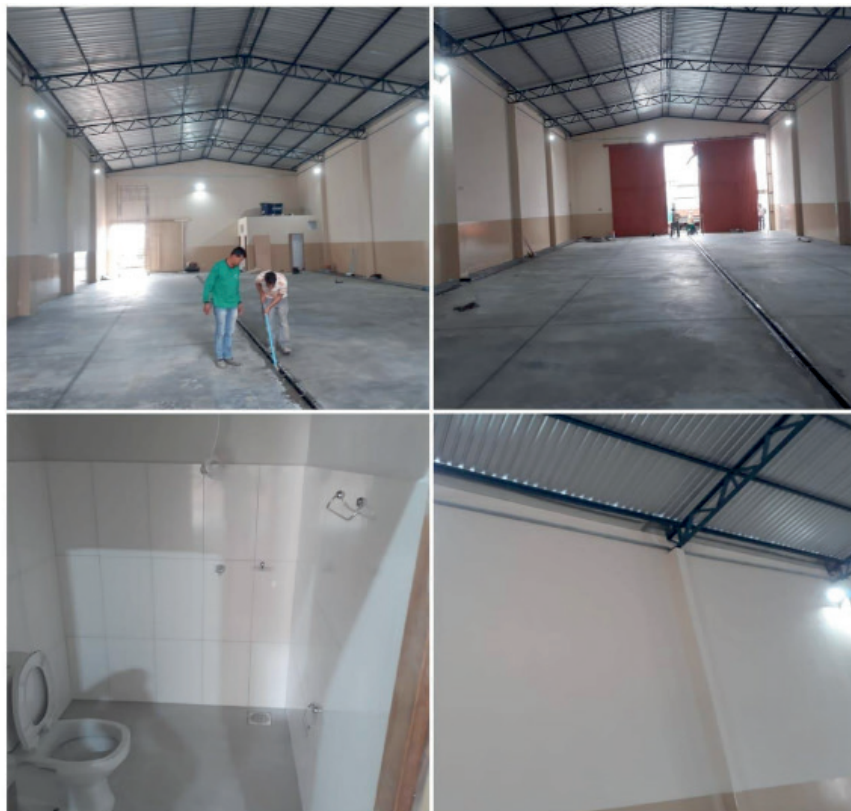
FIGURA 5. Implantação do acabamento final e elétrica, na construção de um barracão agrícola, município de Mineiros, Estado de Goiás, 2020.
