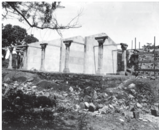
Figura 3: Construção do Museu das Missões e da Casa do Zelador (1939-1940).
