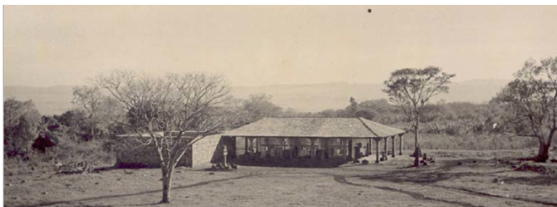
Figura 5: O Pavilhão Lucio Costa e a Casa do Zelador (1940).
