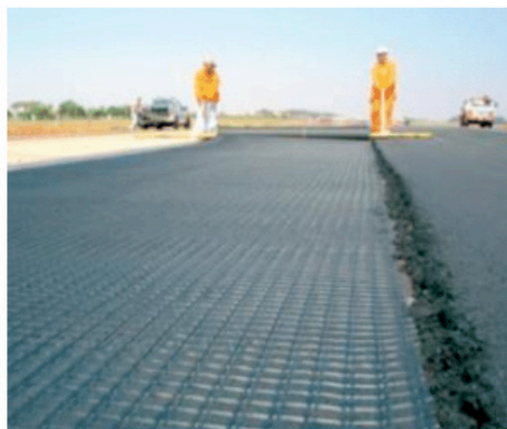
Figura 4. Aplicação de geossintéticos em pavimentos: a) geotêxteis; b) geogrelhas (Bernucci et al., 2006).
