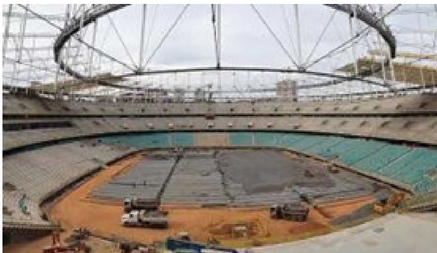
Figura 5. Geossintético utilizado na drenagem do Estádio Arena
