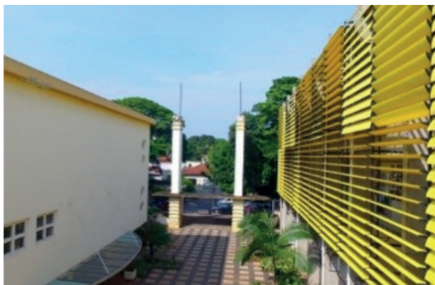
Figura 4: Foto do pórtico antes da reforma prevista para 2020 – autores.
