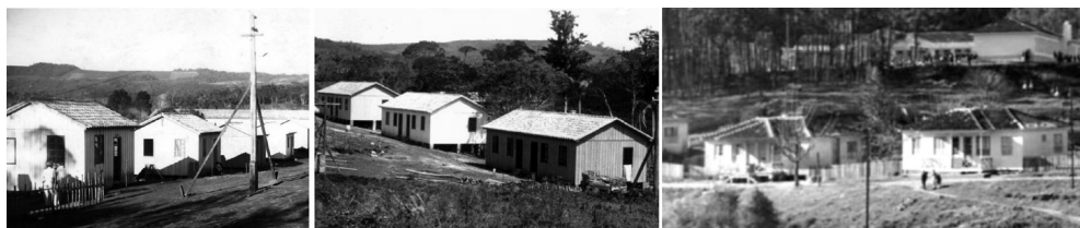
Figura 2 – Tipologias habitacionais na vila operária de Rio Fiorita entre as décadas de 1940 e 1950
