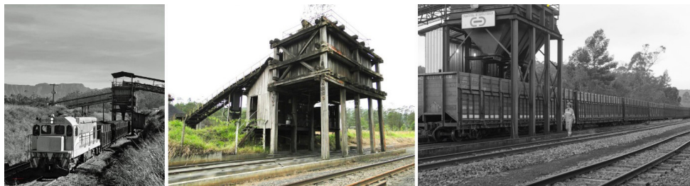
Figura 5 - Estruturas para em embarque de carvão presentes em Rio Fiorita
