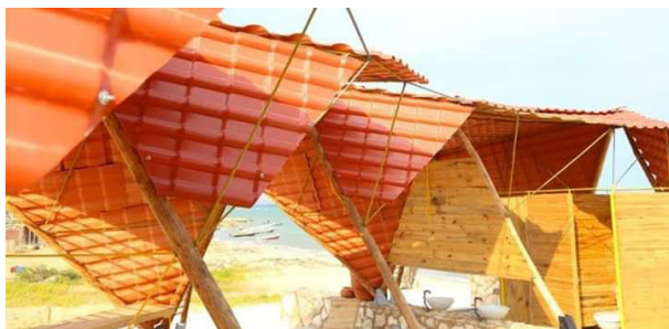
Figura 7 – Estação de Serviço Punta Arenas, Venezuela (2015). Pico Colectivo
