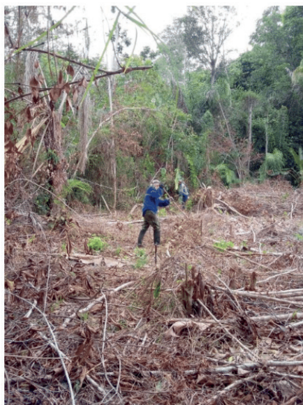
Figura 01. Início do preparo da área.
