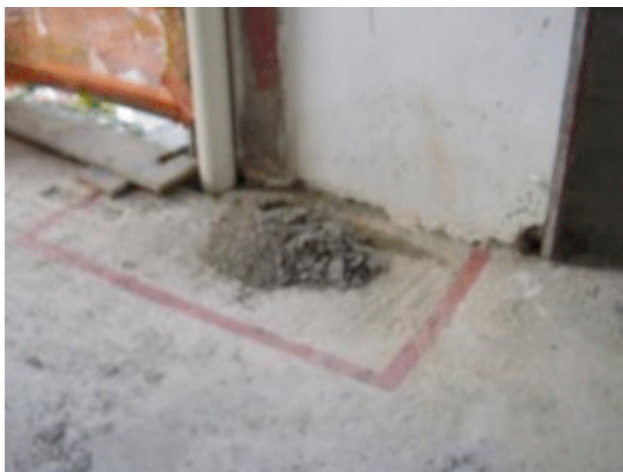
Figura 3 - Demarcação no piso para deposição de resíduos classe A.
