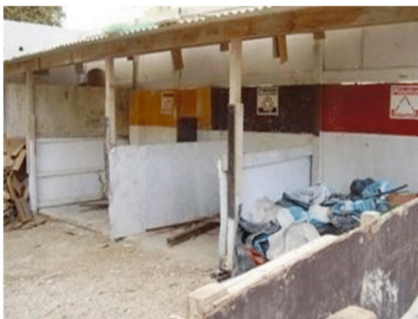
Figura 4 - Baias fixas para acondicionamento final dos resíduos.
