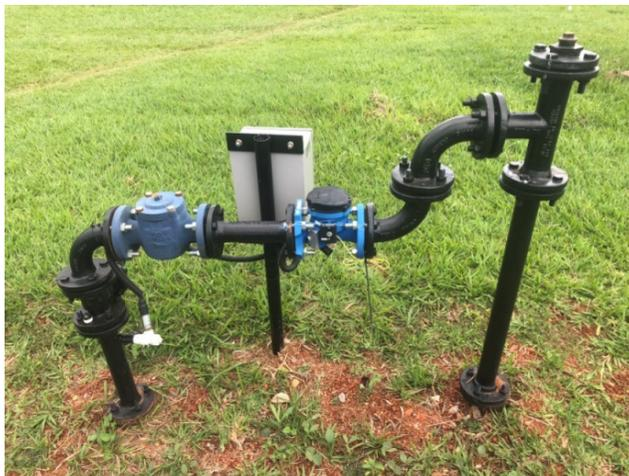
Figura 5. Cavalete com hidrômetro ultrassônico instalado na saída sul do ICC.
