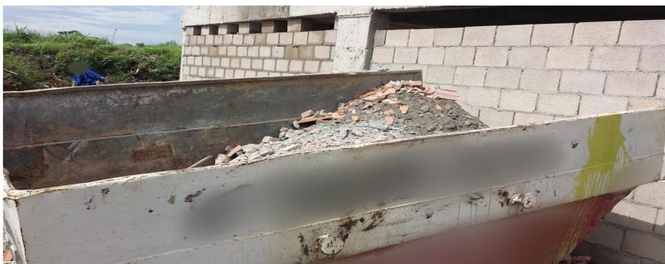
Figura 5 – Containers para armazenamento de RCC na obra 2.
