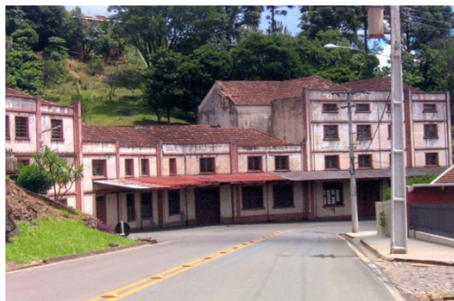
Fotografia 7 - Vista frontal do prédio da antiga Indústria de Bebidas Balvedi.
