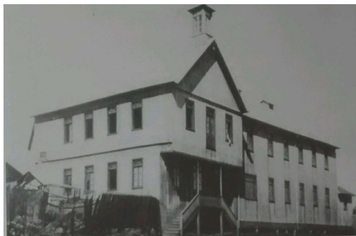
Fotografia 3 - Vista frontal e parcialmente lateral do primeiro prédio da Sociedade de Mútuo Socorro XX de Setembro.
