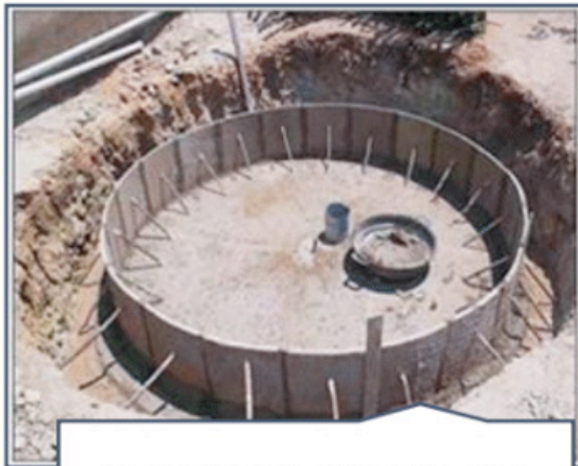
Execução da alvenaria com placa de cimento pré-moldada
