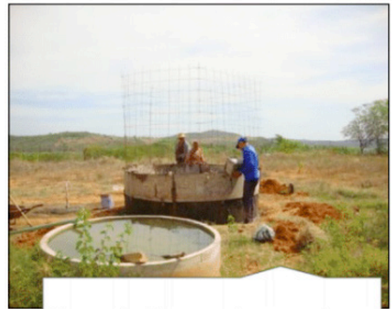
Execução da concretagem na forma (manilha) de aço
