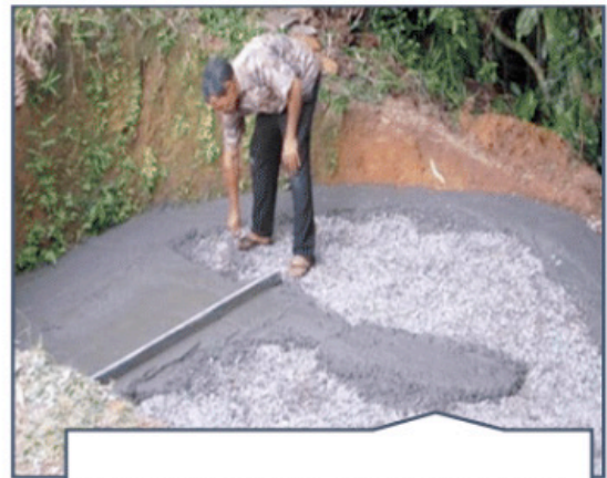
Formação da base da cisterna - contra piso em concreto
