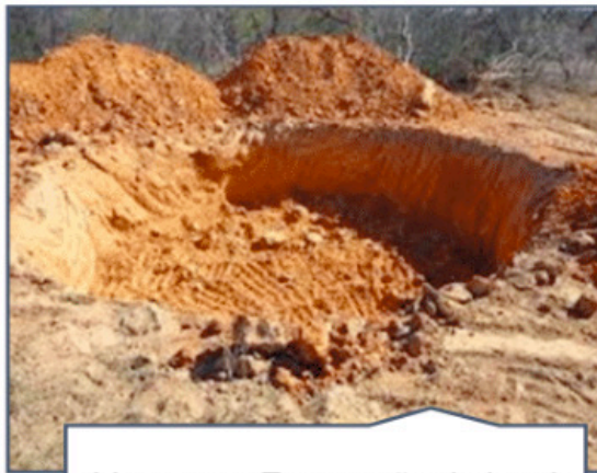
Limpeza e Escavação do local da construção da cisterna
