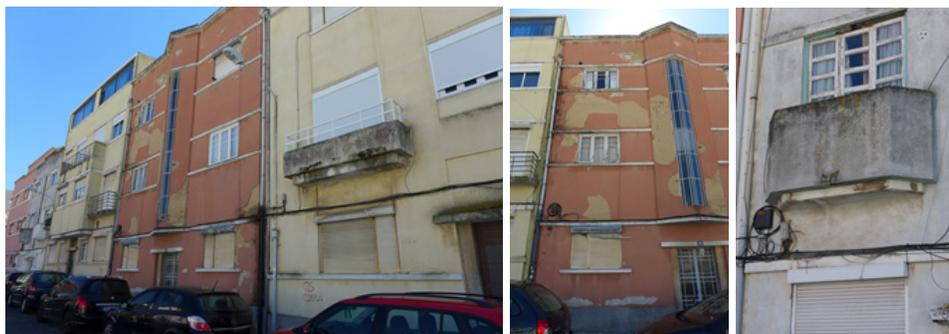
Figuras 12, 13, 14 - Fachadas degradadas de edifícios recentes. (Reaes Pinto)
