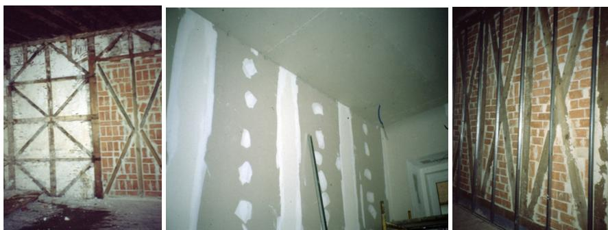
Figuras 9, 10, 11 - Reabilitação de paredes resistentes interiores de edifícios Pombalinos. O reboco poderá ser estruturado com uma malha fina de aço ou de fibra de vidro (para evitar fissurações originadas por comportamentos diferentes de paredes existente e novas) ou em alternativa por placas de gesso cartonado, reduzindo os resíduos no local da obra. (Reaes Pinto)
