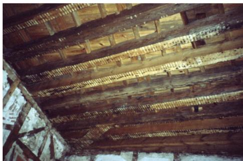
Fig 3 - Elementos estruturais de pavimentos tradicionais (Reaes Pinto)
