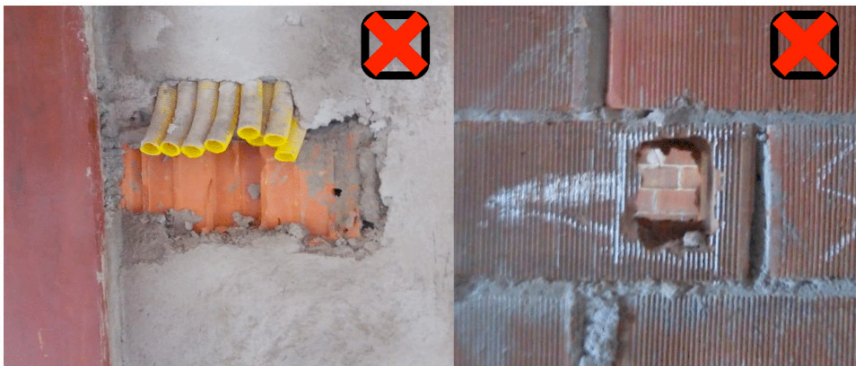
Figura 04: Rasgos para colocação de caixas elétricas
