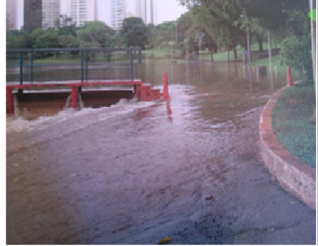
BARRAGEM TRANSBORDA. INUNDANDO A PISTA DE CAMINHADA
