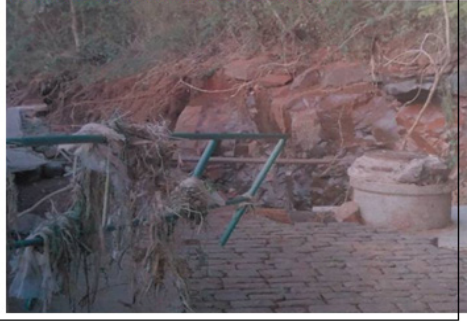
NO PARQUE ARTHUR THOMAS A PISTA DE CAMINHADA E AS TUBULACOES FORAM DESTRUÍDAS PELAS INUNDAÇÕES.
