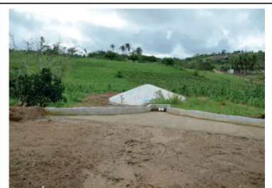
Figura 3 - Cisterna de Enxurrada
