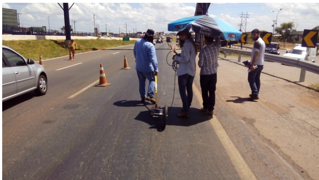
Figura 3 - Fotografia evidencia a aquisição de dados de GPR com o sistema SIR3000 acoplado a uma antena blindada de 900MHz.
