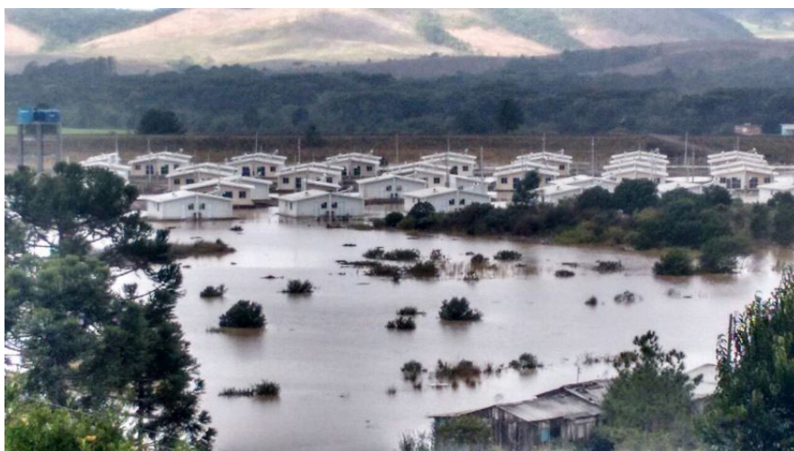
Figura 5 - Registro do fenômeno inundação no Condomínio Ponte Grande, em tempestade ocorrida em junho de 2017.
