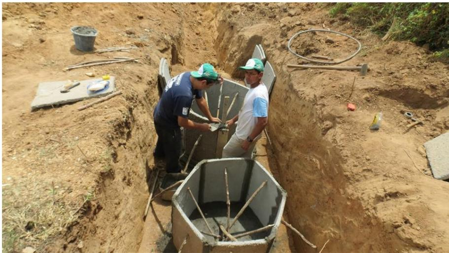
Figura 06. Montagem e vedação das caixas (Bertópolis)
