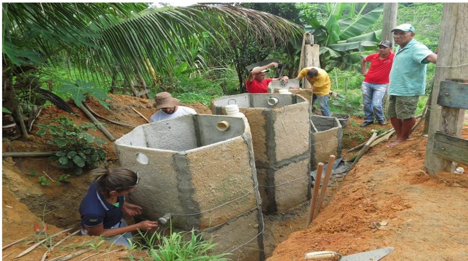
Figura 07. Amarração das caixas com arame e instalação de tubos e conexões (Crisólita)
