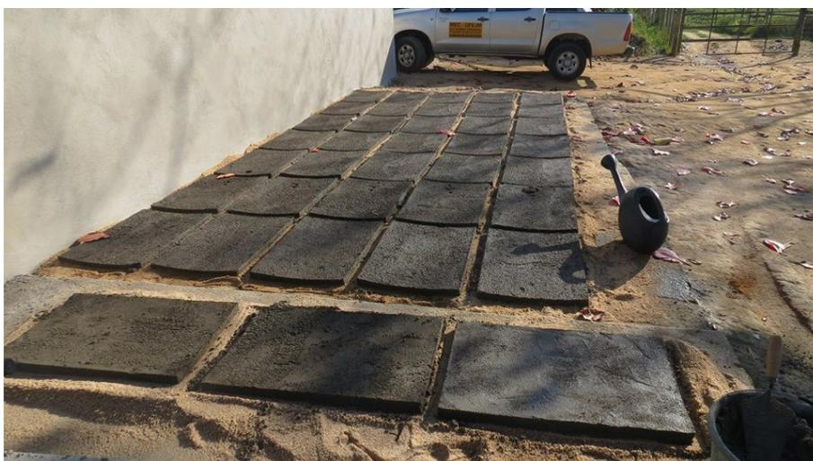
Figura 04. Placas feitas com molde e em processo de secagem (Novo Oriente de Minas)
