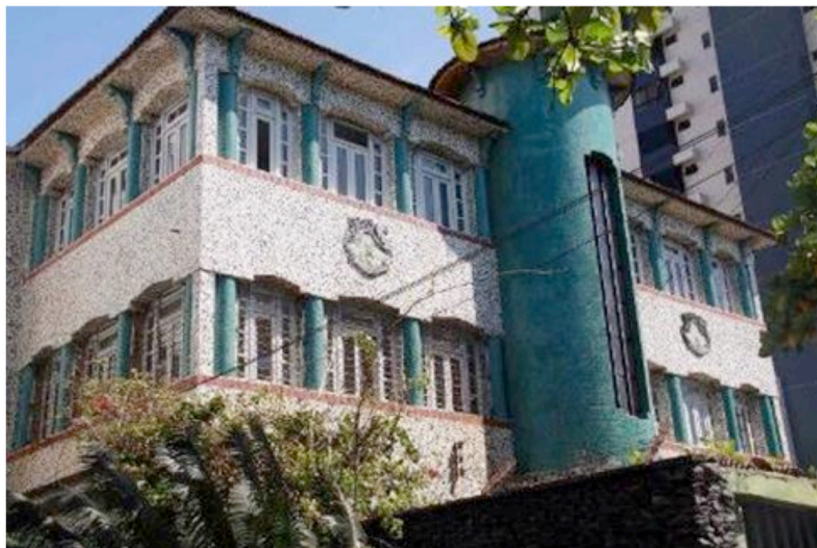
Figura 01. Vista da fachada frontal do Edifício Caçara em 2011, quando do início das discussões sobre a sua preservação. Fonte: fotografia Nani Azevedo.
