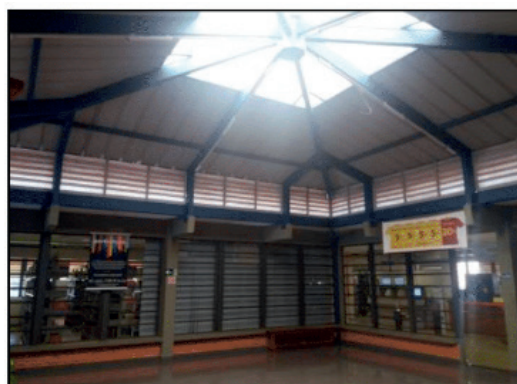
Figura 4 – Aberturas voltadas para o átrio da biblioteca.
