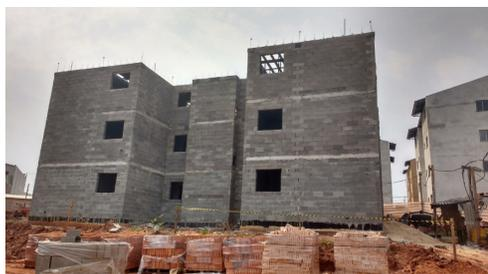
Figura 5 – Empreendimento em alvenaria estrutural.
