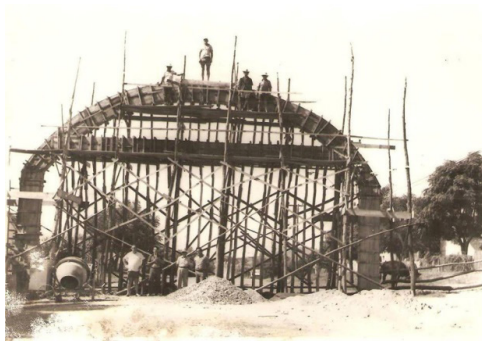
Fotografia da construção do Arco em homenagem ao centenário de emancipação do município de São Francisco de Assis.
