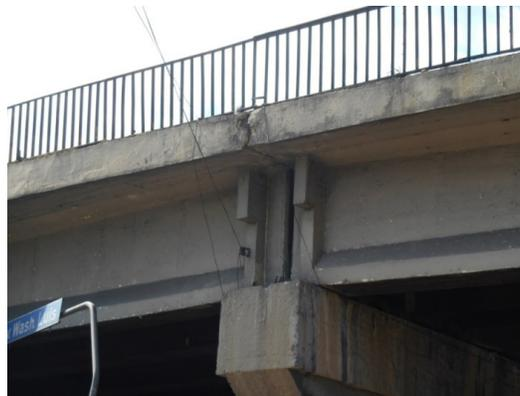
Figura 14 - Aparelho de apoio não visualizado (Autor)
