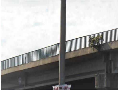
Figura 15 - Vegetação da área da junta de dilatação (Autor)
