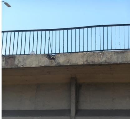
Figura 11 - Concreto disgregado na laje de passeio (Autor)
