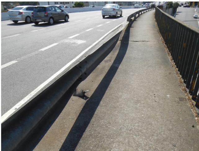
Figura 22 – Defesa metálica com desalinhamento (Autor)
