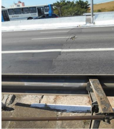
Figura 19 - Fissuras e remendos presentes na pista (Autor)
