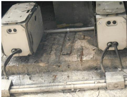
Figura 13 - Armadura exposta e oxidada (Autor)
