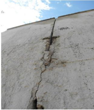
Figura 17 – Muro da ala com fissuras e armadura exposta (Autor)
