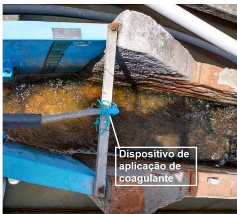
Figura 2 – Foto Ilustrativa da Estapa de Coagulação e Mistura Rápida em calha Parshall na ETA-TB.
